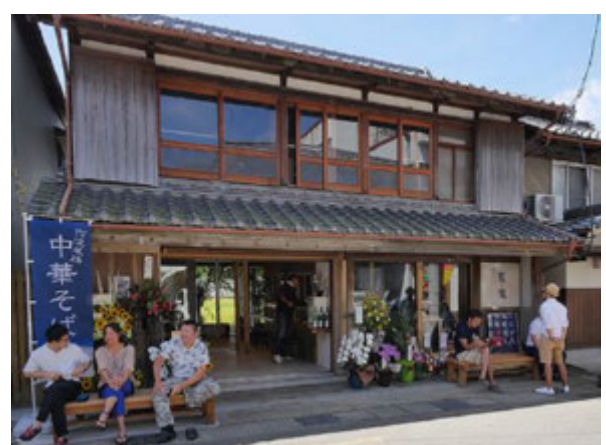
古民家永晴邸改修プロジェクト/徳島/2018
