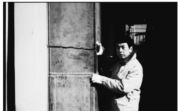
図20 柱材の引張破壊
