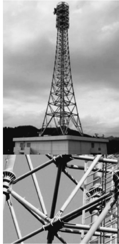
図39 中部電力通信鉄塔の耐震補強
