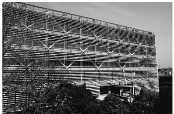
図31 東工大緑ヶ丘1号館耐震補強
