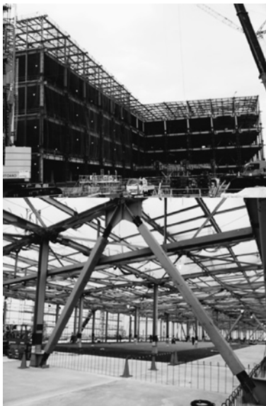
図38 DPL 川崎夜光物流施設
