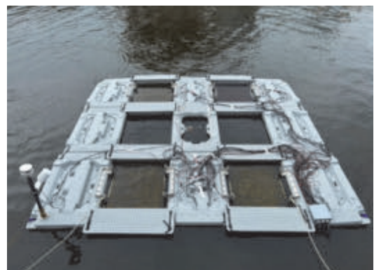
図9 MM21に設置した海中ソーラー発電システム
